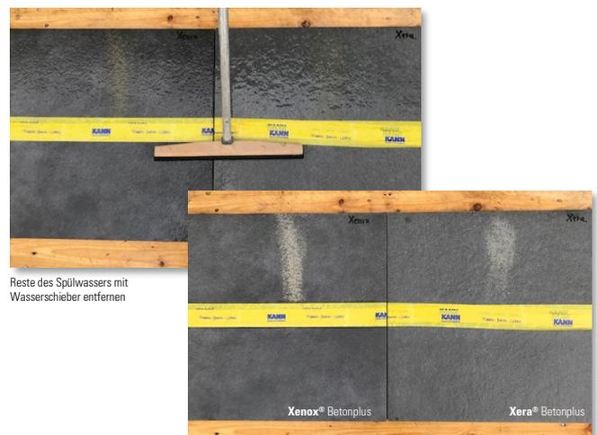
Reste des Spülwassers mit Wasserschieber entfernen
