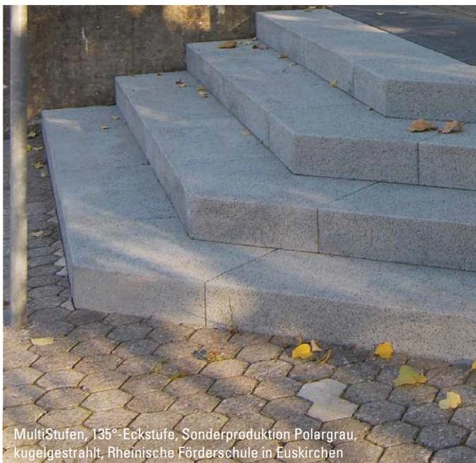
MultiStufen, 135°-Eckstufe, Sonderproduktion Polargrau, kugeligestrahlt, Rheinische Förderschule in Euskirchen
