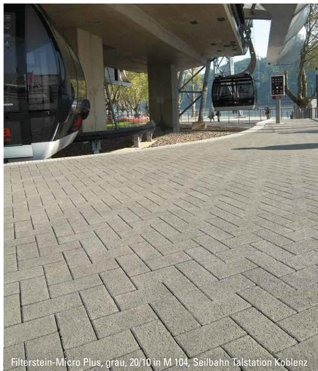
Filterstein-Micro Plus, grau, 20/10 in M 104, Seilbahn Talstation Koblenz
